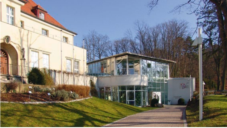
Eingangsbereich nach der Erweiterung 1996
